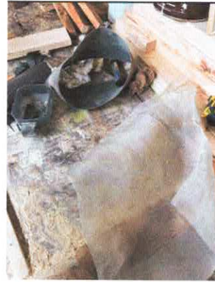
Imagen 6. Apoyo en la elaboración de marcos de madera
