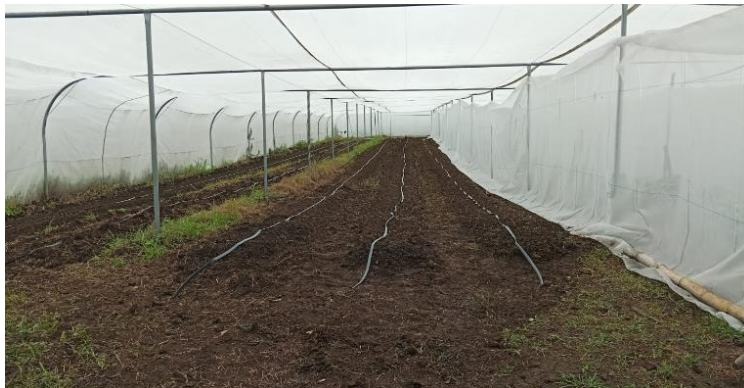
Figura 12. Colocación riego por goteo
