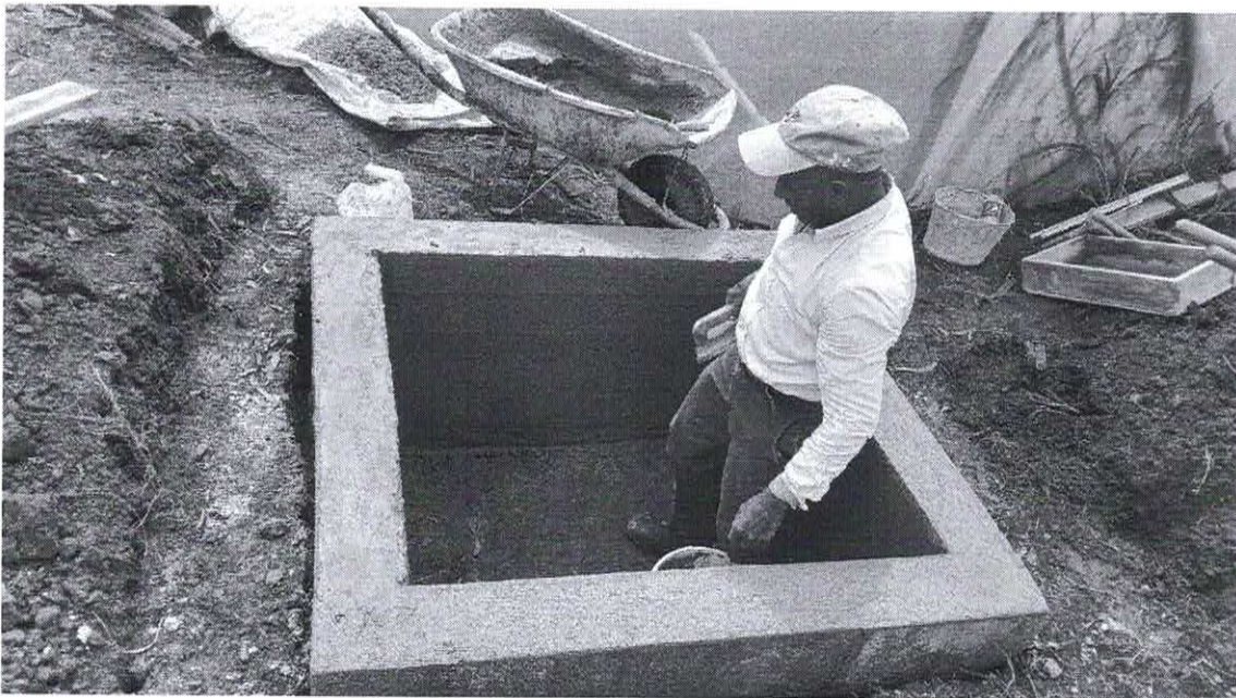
Imagen 6. Avance con la construcción de la cama Biológica con la ayuda de un maestro de obras de la ENCA
